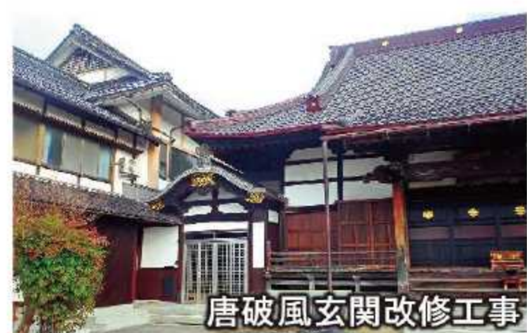
唐破風玄関改修工事 善久寺様 鳥取県鳥取市
