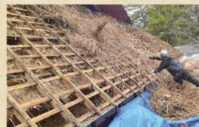
▶屋根の下に「隠されていた茅」の撤去
