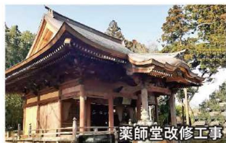
薬師堂改修工事 密蔵院様 千葉県佐倉市
