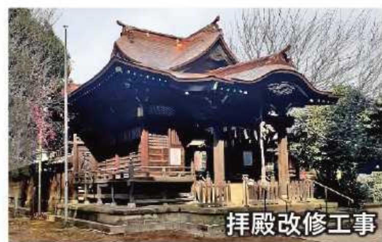
拝殿改修工事 日枝神社様 東京都大田区
