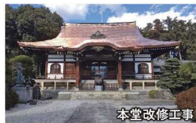
本堂改修工事 谷雲寺様 埼玉県日高市
