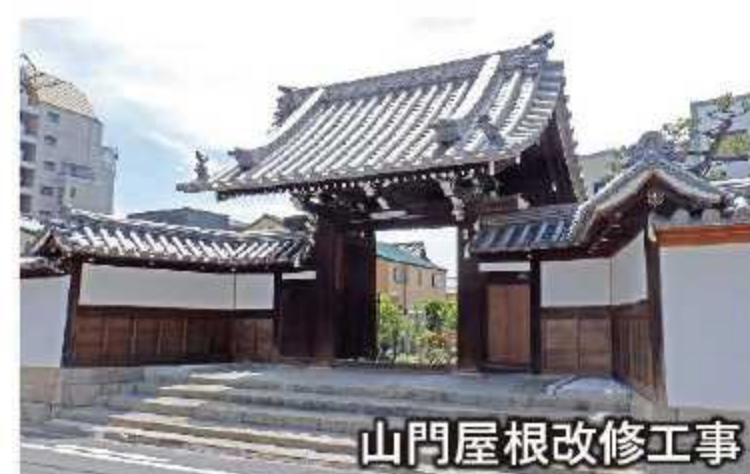
山門屋根改修工事 大乘寺様 大阪府大阪市
