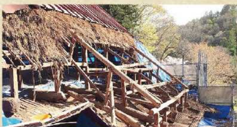
▶屋根下地の再構築
