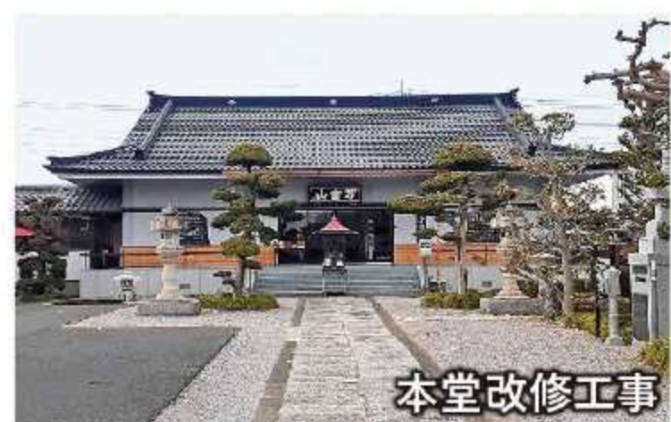
本堂改修工事 見性院様 埼玉県熊谷市
