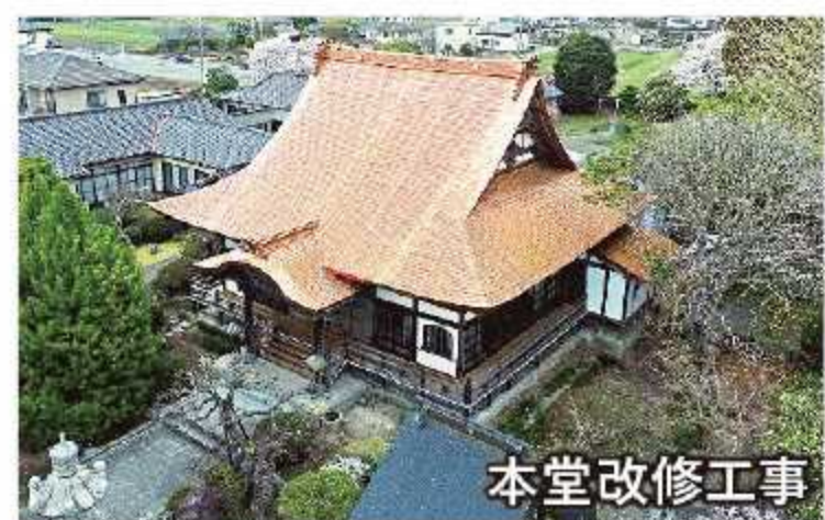
本堂改修工事 金剛定寺様 栃木県宇都宮市
