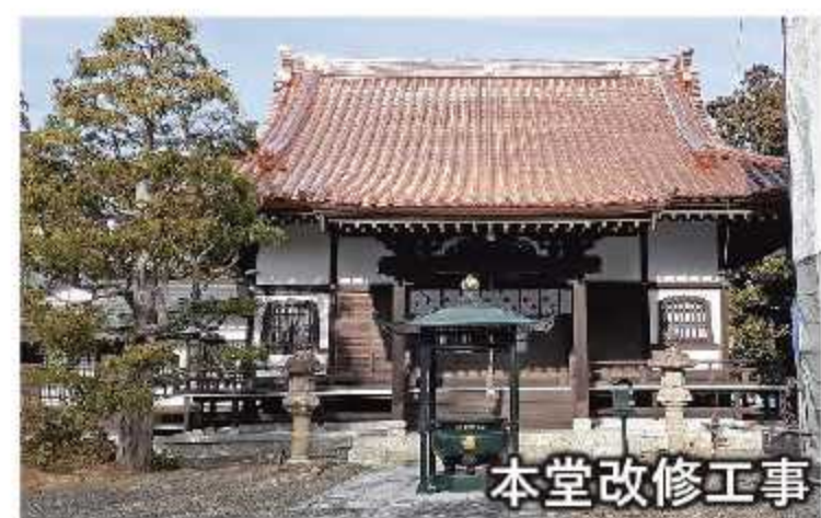
本堂改修工事 廣徳院様 福島県双葉郡橋本町
