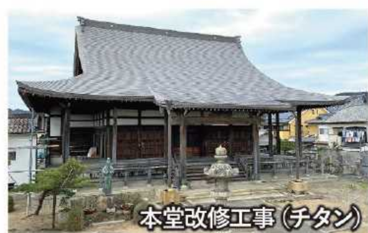
本堂改修工事(チタン) 萬福寺様 兵庫県赤穂市
