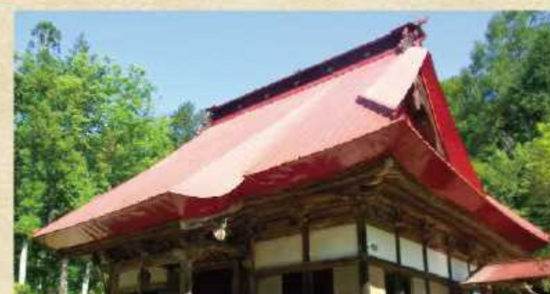
▶工事前(金属屋根を被せた茅葺き屋根)
