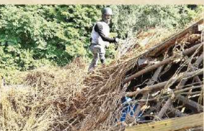
▶屋根下地の再構築
